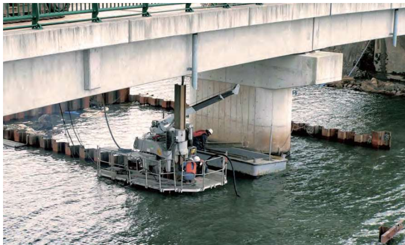
上部障害クリア工法による空頭制限下での橋梁拡幅工事(下部工)
