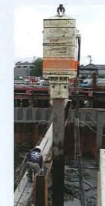
杭規格：H400×400 (L=32m引抜き) 発注：広島市 工事名：平和橋(仮称)架替工事
