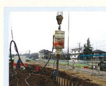
矢板規格：SP-III型 (L=10.5m) 発注：国土交通省 工事名：日野共同溝工事
