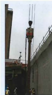
杭規格：H400×400 (L=16m) 発注：JR東日本 工事名：品川駅ハツ山アンダーパス新設
