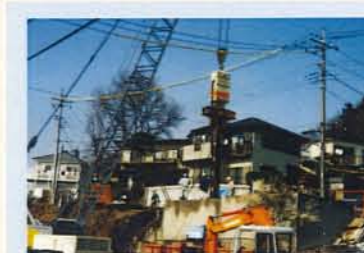
杭規格：φ500×15m 発注：東京都 工事名：道路改修工事及び補償代行工事
