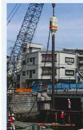
杭規格：H350×350 (L=34m) 発注：横浜市 工事名：坂下橋架替工事
