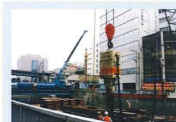
杭規格：H350×350 (L=16m) 発注：東京都 工事名：目黒川大崎橋架替工事
