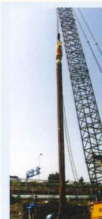
矢板規格：SP-IIIw型 (L=21m) 発注：神奈川県 工事名：相模川流域下水道左岸処理場土留工事
