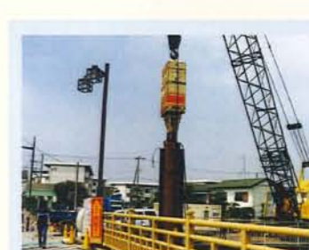
杭規格：φ600×12m 発注：神奈川県 工事名：総合治水対策特定河川工事(引地川)
