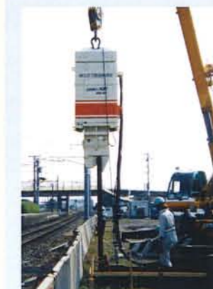
矢板規格：SP-II型 (L=6m) 発注：JR九州 工事名：羽犬塚駅構内自由路新設他
