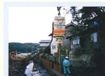
矢板規格：SP-II型 (L=8m) 発注：石川県 工事名：大谷川広域基幹河川改修工事
