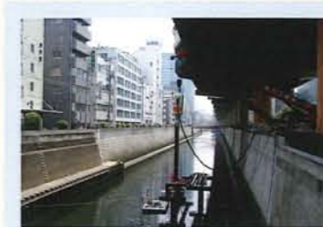
杭規格：H350×350 (L=17.5m) 発注：東京都 工事名：神田川整備工事
